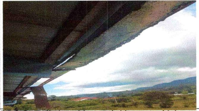
Foto 2: Sustitución de canal de aguas pluviales con gran deterioro.
